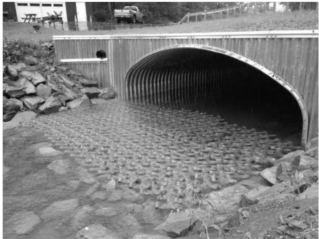
A-JACKS PARTIAL INVERT N.T.S.
